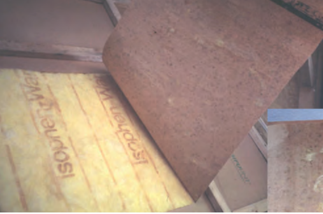
Condensatie recht tegenover de achter- zijde van het dampscherm (Illustratie Fraunhofer- Institut)
