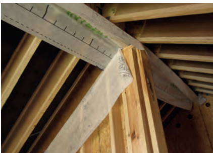
Aansluiting tussen wand en nok De continuïteit van de luchtbarrière wordt door een wachtmembraan verzekerd (illustratie magazine WTCB-Contact n° 33, 2012)
