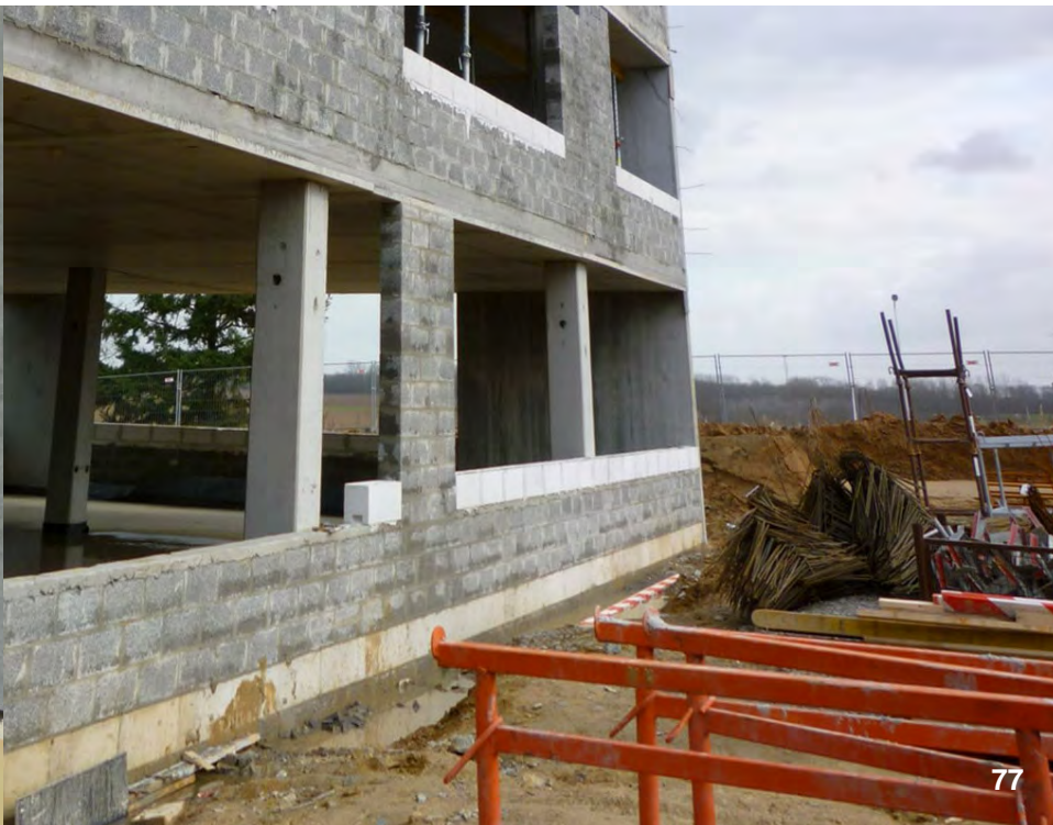
Aansluiting met plaatsing van een blok isolerend materiaal in het metselwerk: \Psi = -0,02 \text{ W/m.K}
