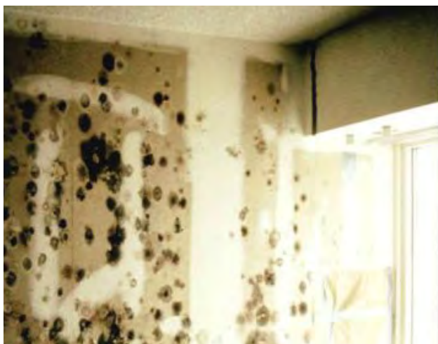
Voorbeeld van schimmel als gevolg van interne condensatie. ( Joe Lstiburek ).
